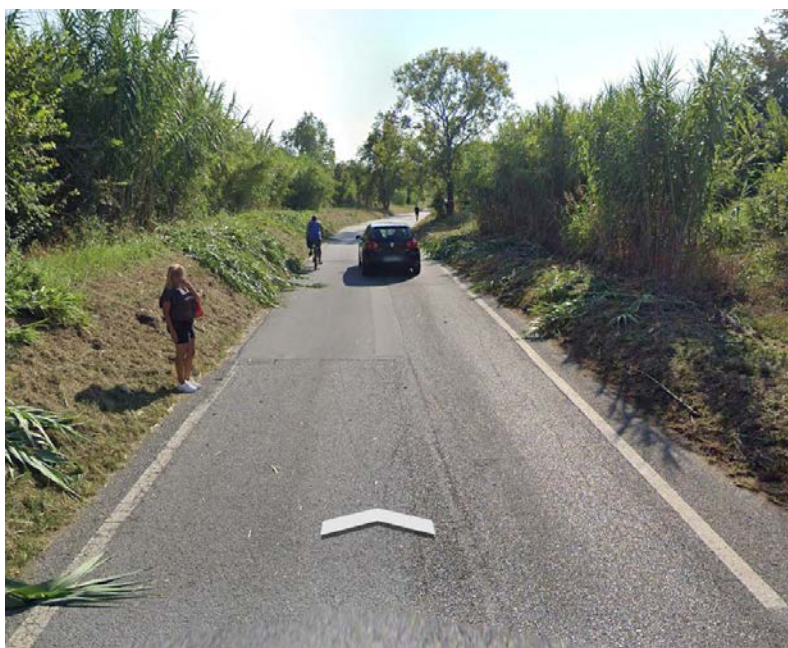
Figura 2 - Stato di fatto
