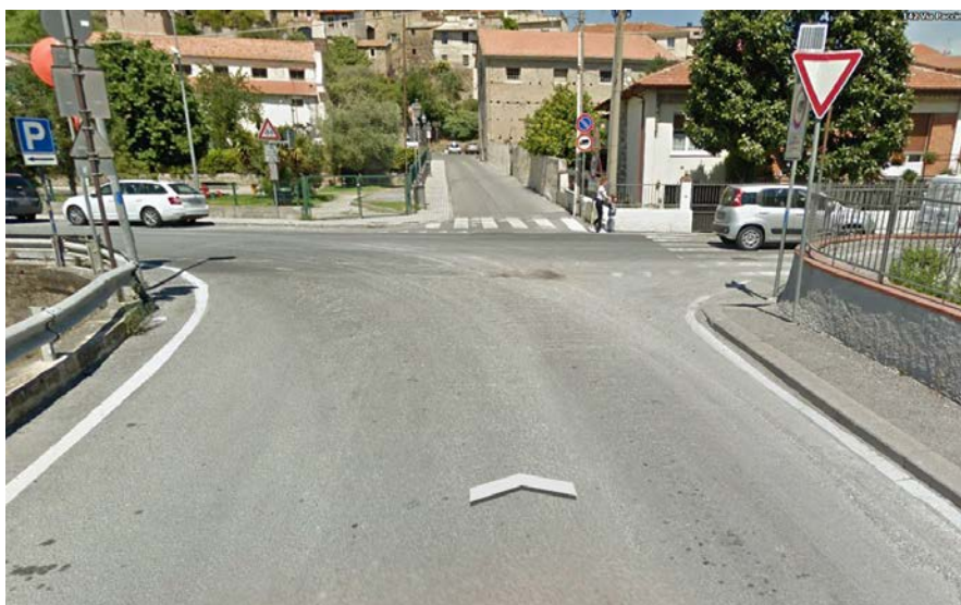
Figura 2 - Stato di fatto
