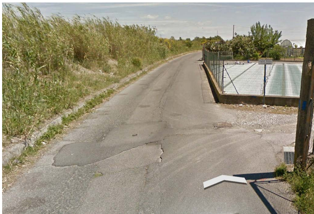
Figura 2 - Stato di fatto
