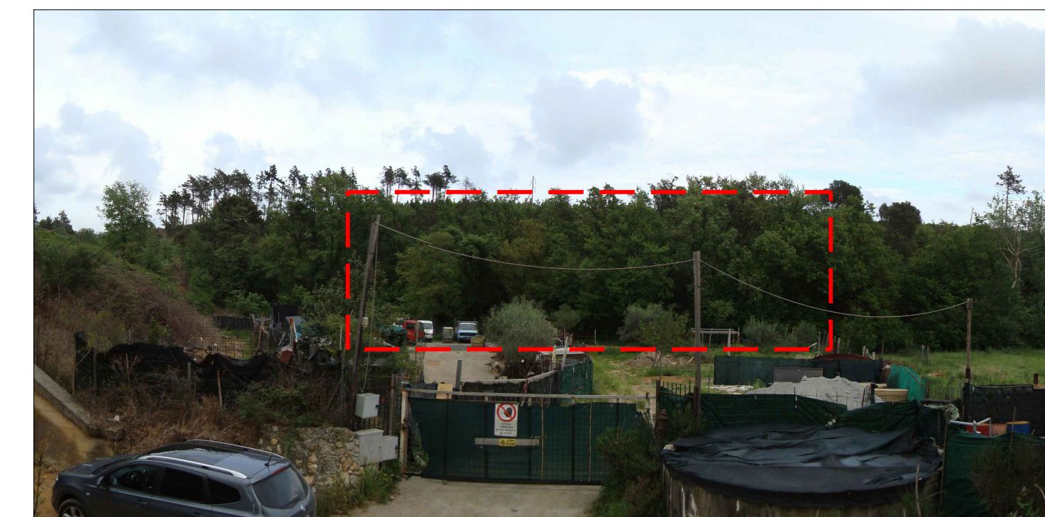
Stop 9 - Zona di imbocco della galleria artificiale lato Andora
