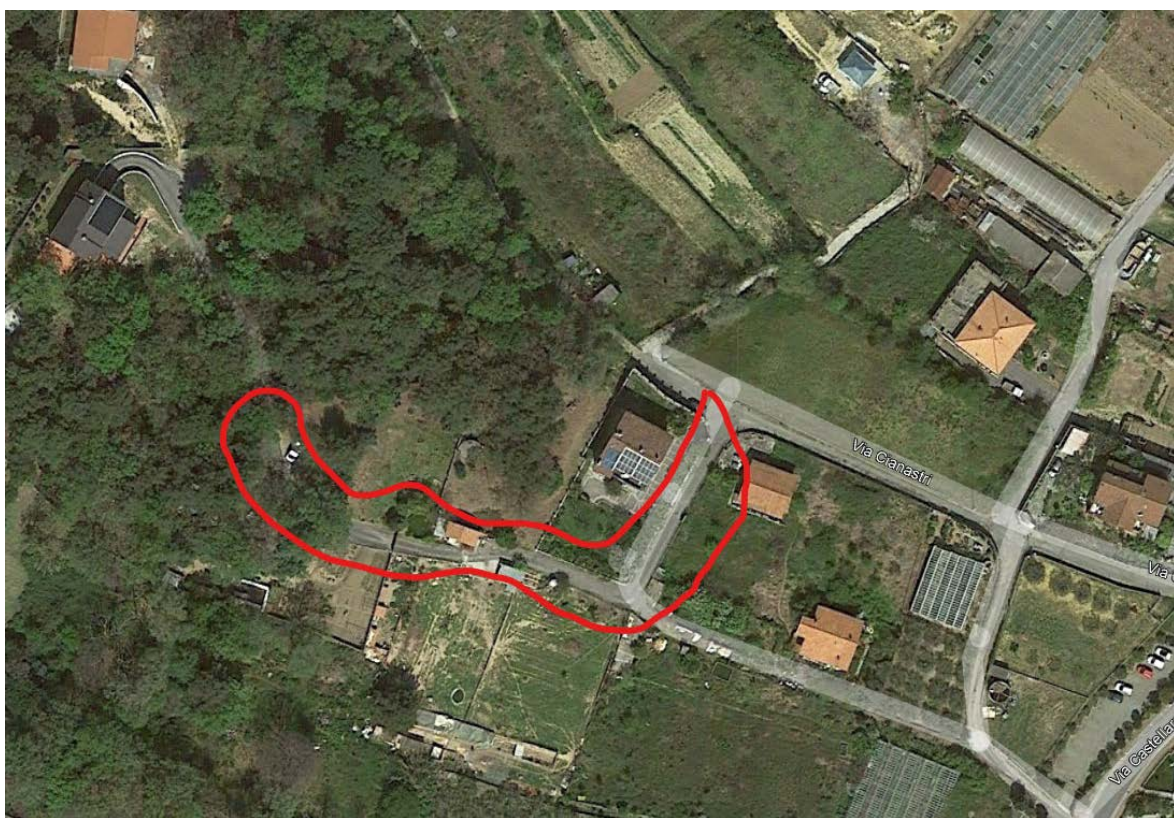
Figura 1 - Stato di fatto – Vista dall’alto
