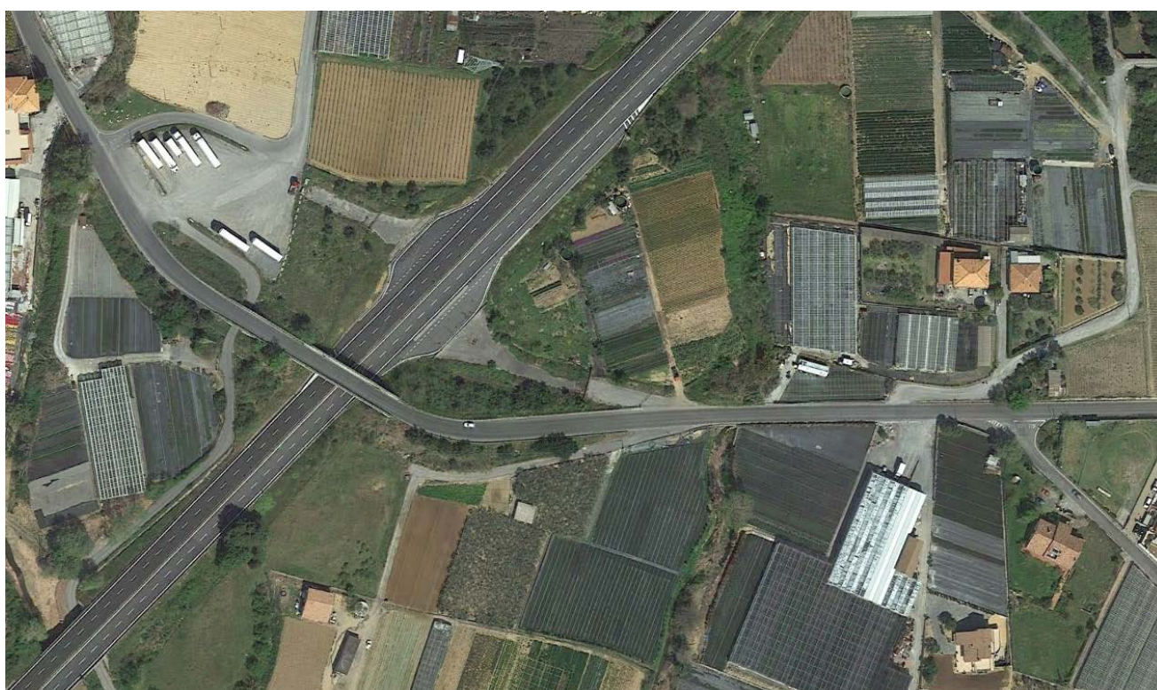
Figura 1 - Stato di fatto - Vista dall'alto
