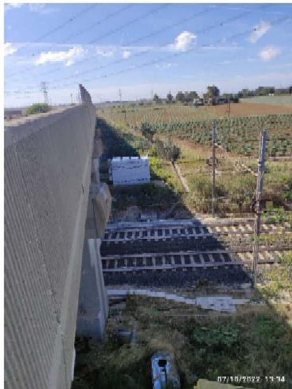
Figura 2.5: Interferenza con linea ferroviaria e presenza ponte
