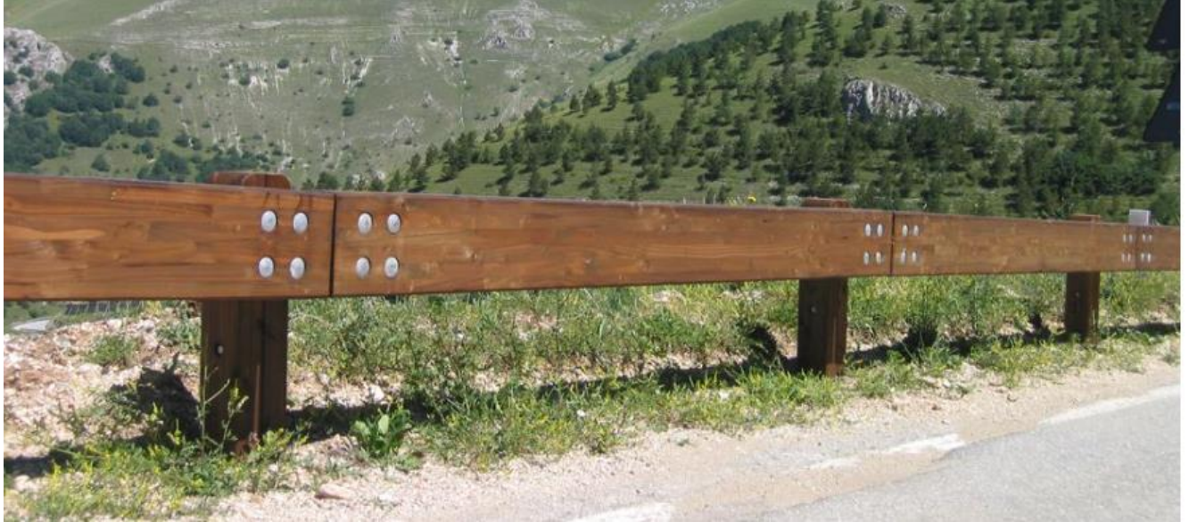
Figura 4-34: Esempio di barriere in acciaio e legno di classe N2
