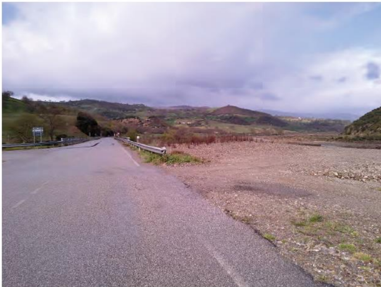
Figura 4-28: Area di trasbordo – Strada Provinciale SP 2
