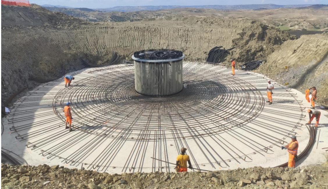
Figura 5-3: immagine tipo posa anchor cages
