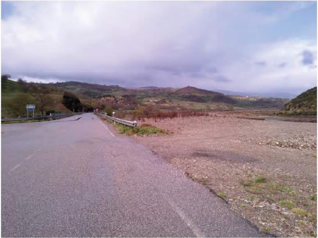
Figura 2.6-1: Area di trasbordo – Strada Provinciale SP 2
