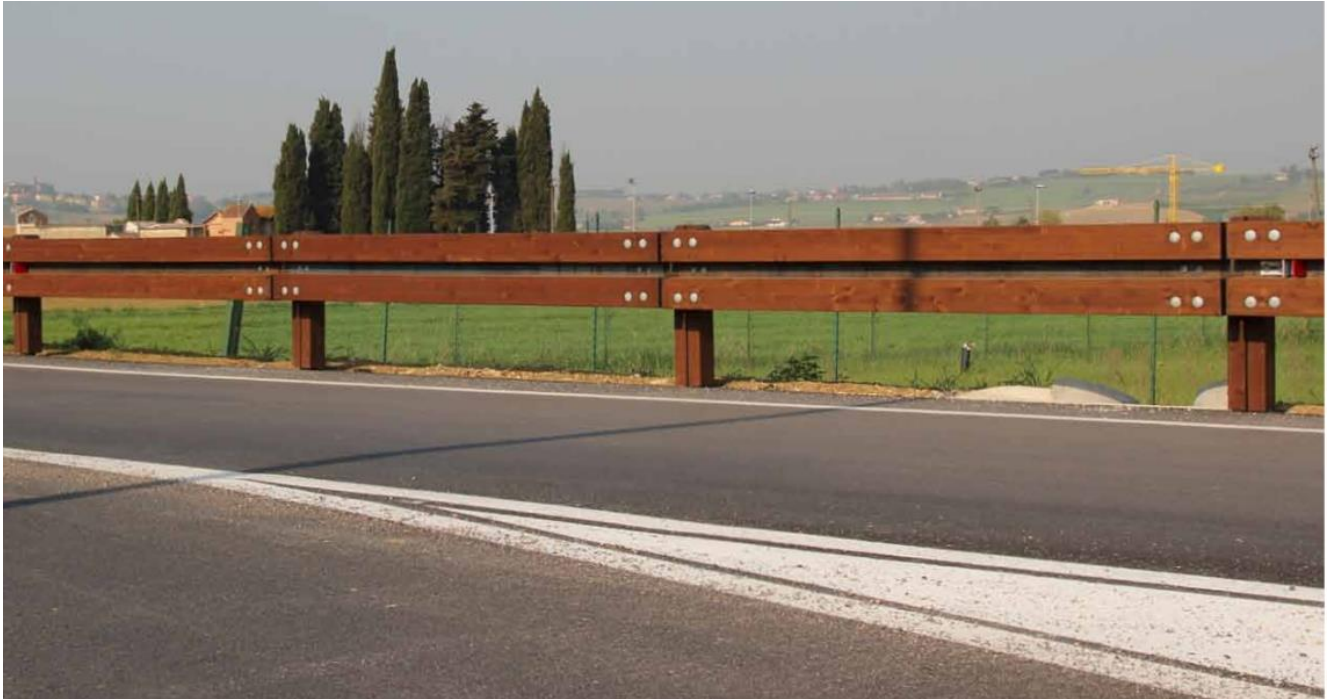
Figura 2.8-5: Esempio di barriere in acciaio e legno di classe H2
