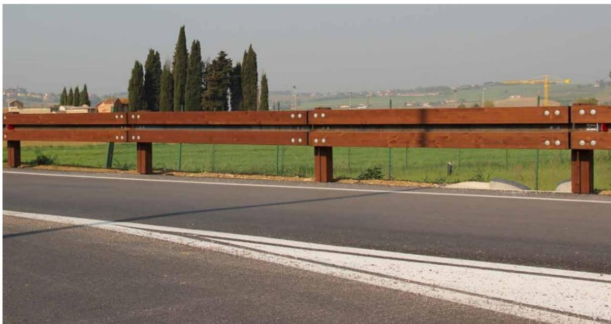
**Figura 4-25: Esempio di barriere in acciaio e legno di classe H2**
