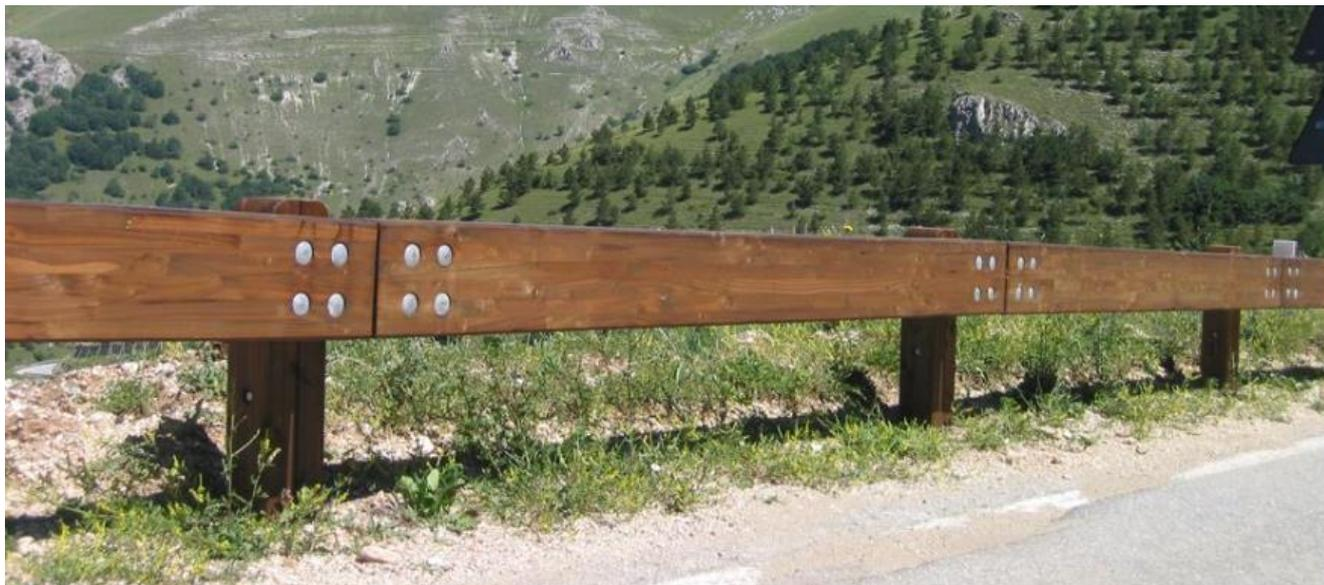
**Figura 4-24: Esempio di barriere in acciaio e legno di classe N2**
