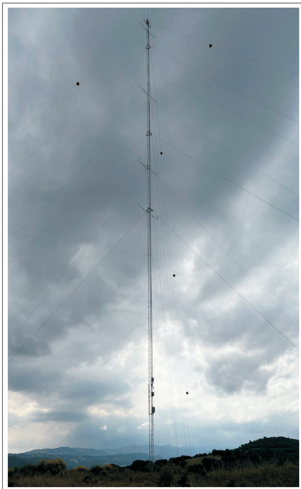
La stazione vista da Est
