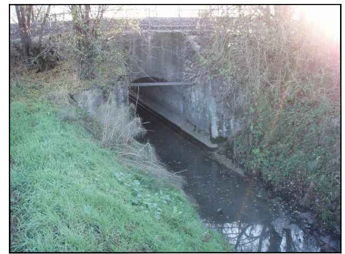
Ponticello in corrispondenza della FF.SS
