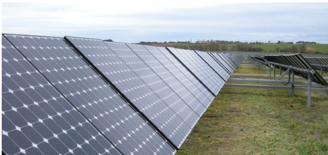
Figura 18 - Stato del terreno inerbito sotto i pannelli fotovoltaici
