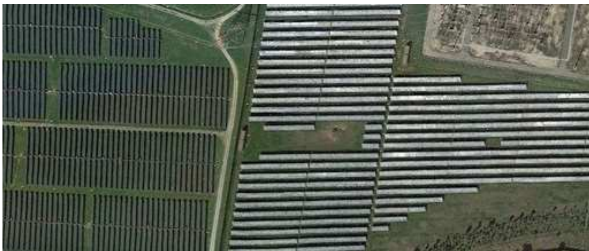
Figura 9 - Confronto impianti fotovoltaici a diversa tecnologia
