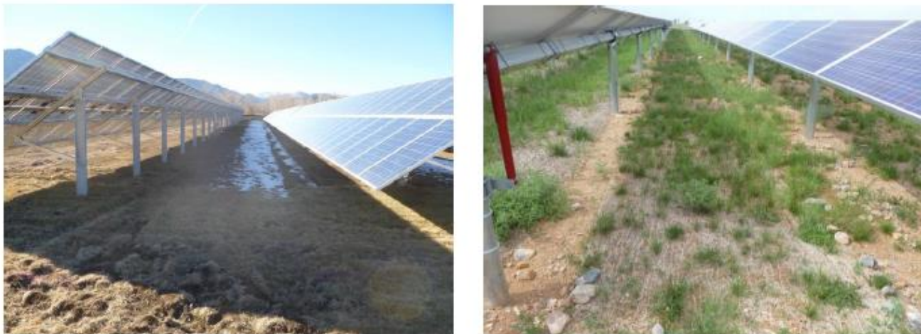
Figura 26- A sinistra file con orientamenti est ovest massimizzano l'ombreggiamento del terreno sottostante, a destra file con orientamento nord sud permettono alla luce solare di raggiungere il suolo. Photo credit: Dave Buckner
