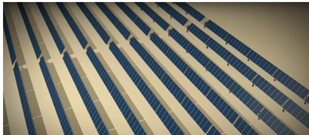
Figura 7. Esempio di inseguitore monoassiale
