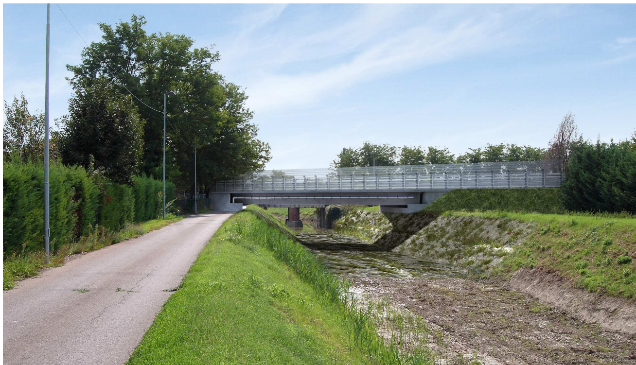
FIGURA 2.4-12 ESEMPIO DI PROTEZIONI ANTIFONICHE TRASPARENTI, PONTE SUL TORRENTE MODOLENA
