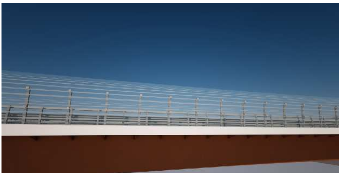
FIGURA 2.4-11 ESEMPIO DI PROTEZIONI ANTIFONICHE TRASPARENTI, VIADOTTO SUL FIUME CROSTOLO
