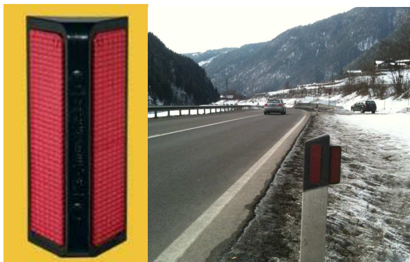
FIGURA 2.2.3-2 – DISSUASORI OTTICI – ESEMPIO REALIZZATO LUNGO LA SS 49 DELLA PUSTERIA (PROVINCIA DI BOLZANO)
