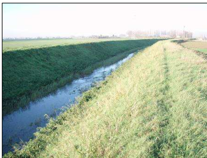
FIGURA 9.1-14 – TORRENTE QUARESIMO IN CORRISPONDENZA DELL'ATTRAVERSAMENTO IN PROGETTO.
