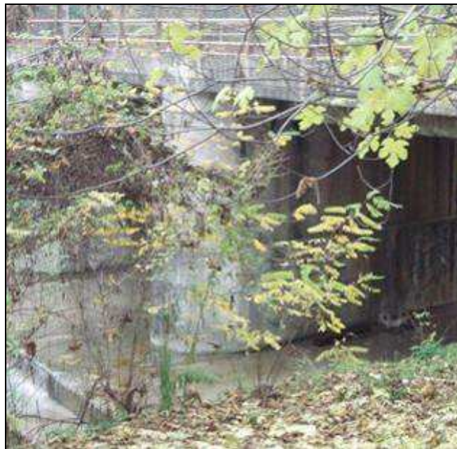
FIGURA 9.1-3 – PONTE FS SUL TORRENTE CROSTOLO
