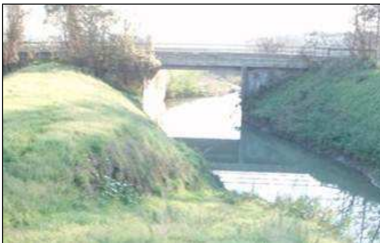
FIGURA 9.1-15 – PONTE FS SUL TORRENTE QUARESIMO.
