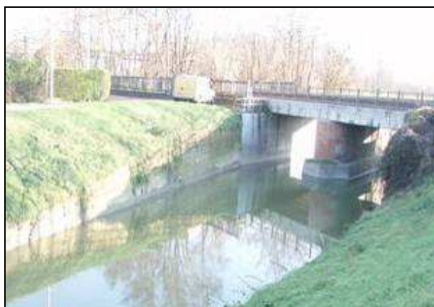
FIGURA 9.1-11 – PONTE FS SU TORRENTE MODOLENA.
