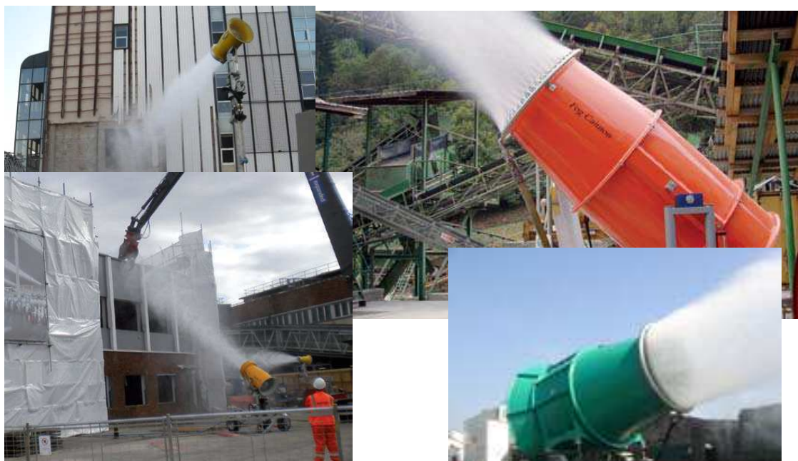
FIGURA 4.3-11 – SISTEMI DI BAGNATURA MEDIANTE CANNONI NEBULIZZATORI.
