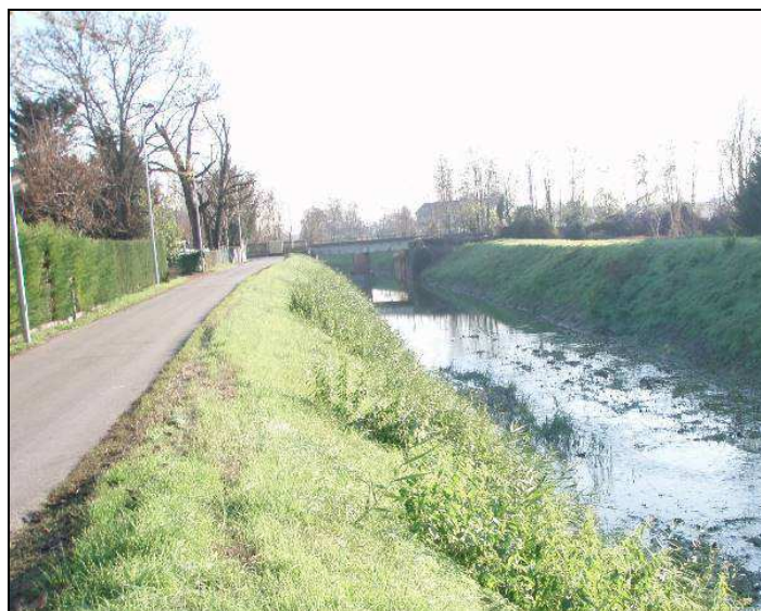
FIGURA 9.1-9 – TORRENTE MODOLENA A VALLE DELL'ATTRAVERSAMENTO DI PROGETTO.
