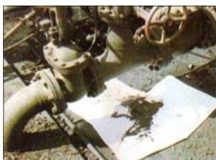
Usa di fogli oleoassorbenti per contenere lo sversamento al suolo di oli minerali
