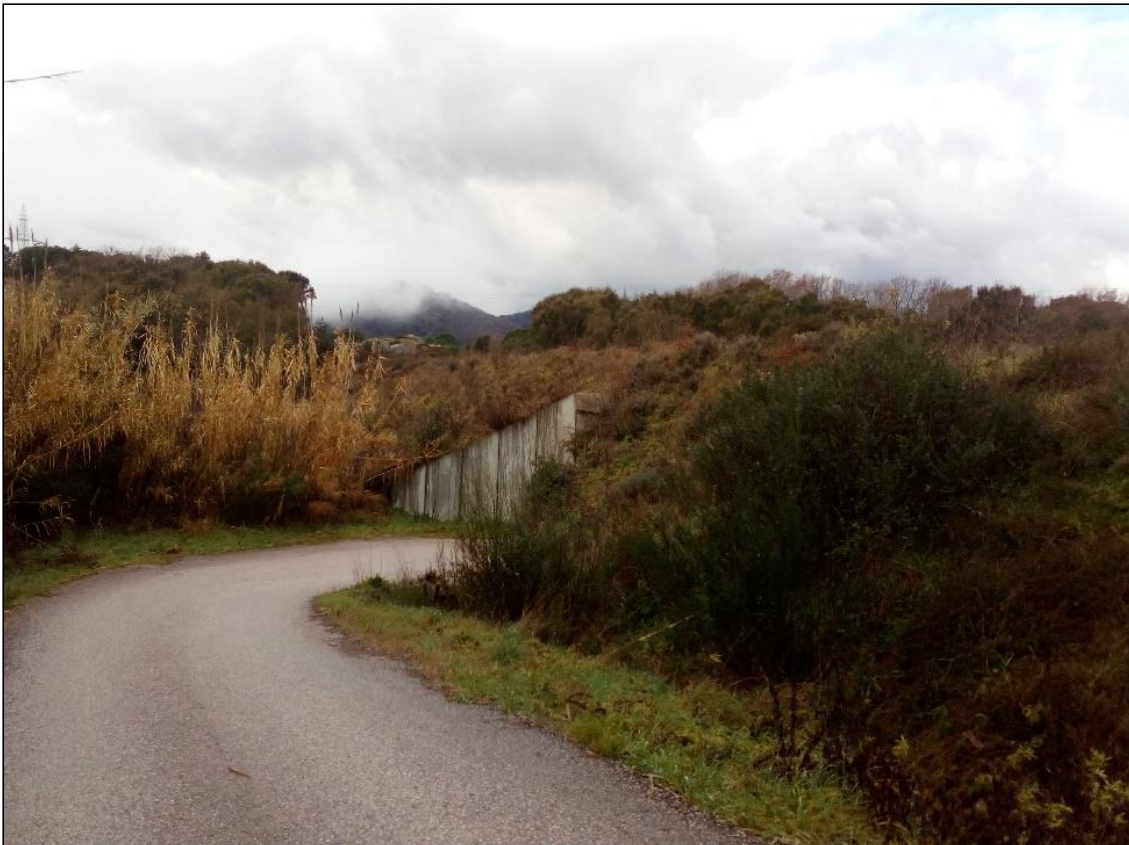
Fig. 5.7 – Rilevato esistente e sottopasso carrabile in corrispondenza delle opere realizzate ed attualmente non in servizio ad inizio del tracciato in progetto. Tratto tra la rotonda in progetto e l'attuale sede della S.S. 133 di Palau.
