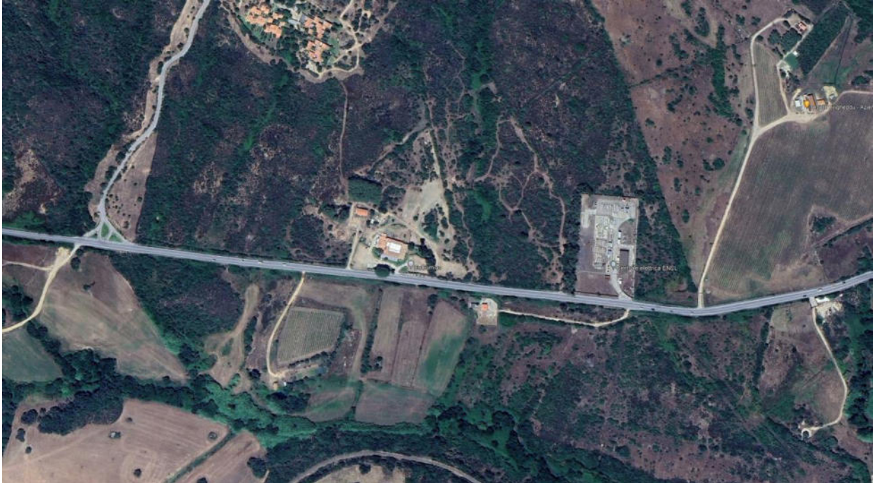
Figura 46 – Accessi sul rettilo della SS125 esistente.
