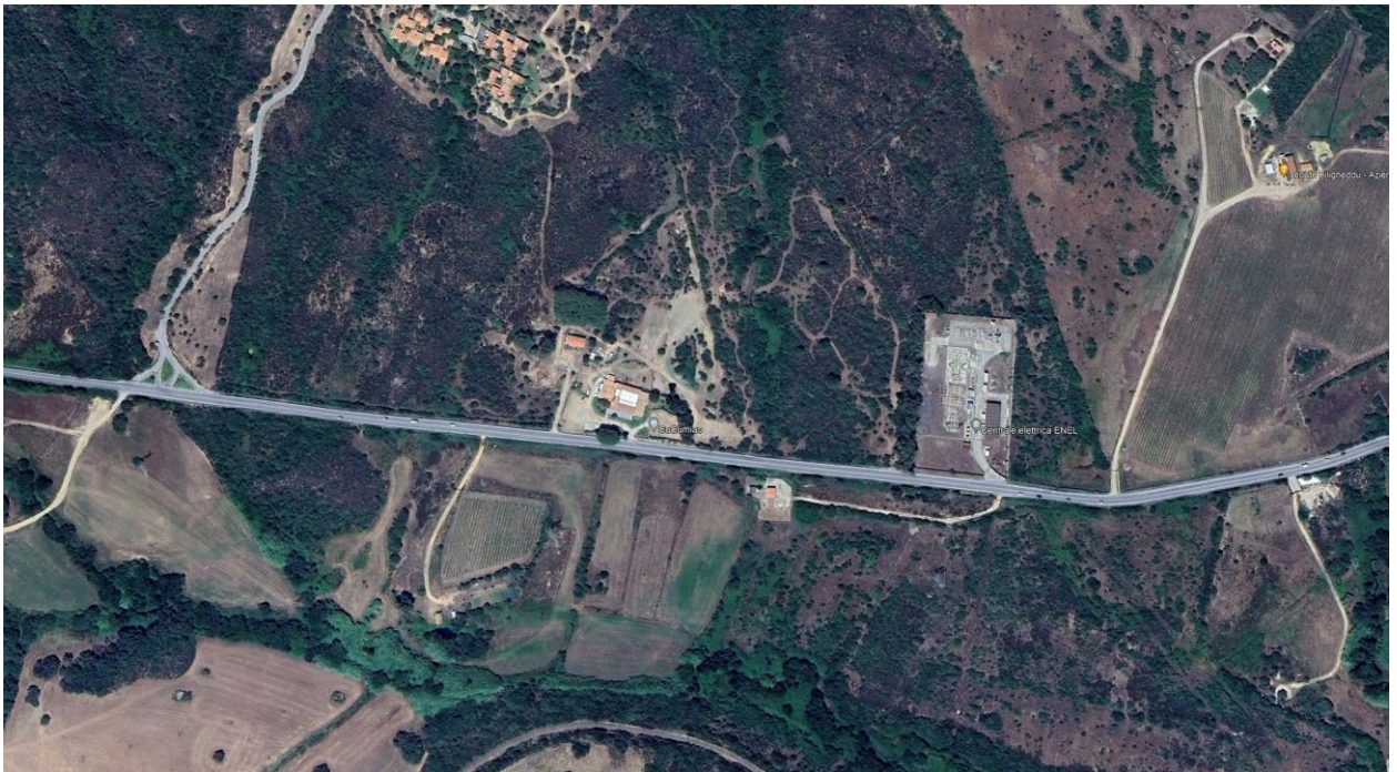
Figura 1-29 – Accessi sul rettilo della SS125 esistente.
