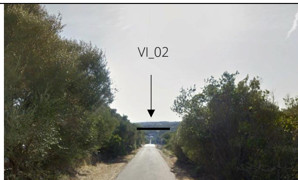
Punto 3 - pk 1+170 ca. - Vista da Via G. Mameli in direzione SO. Da tale punto di osservazione si determina una visuale ravvicinata e diretta del viadotto VI_02 (Viadotto Mameli) solo lungo l'asse stradale della via. Ai lati della carreggiata il viadotto risulta coperto dalla fitta vegetazione.
