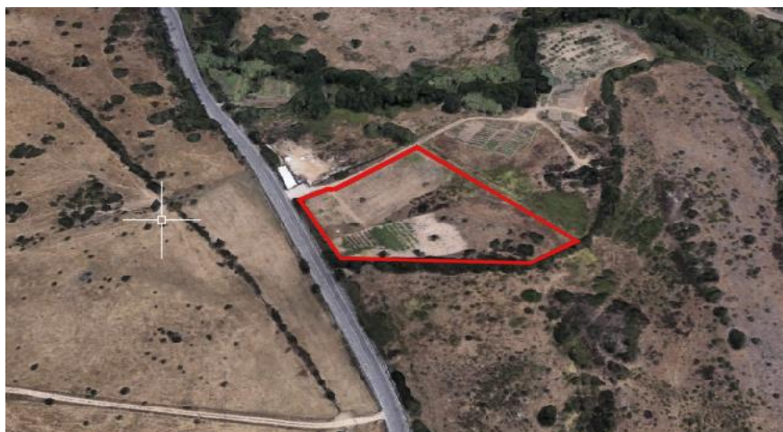
Figura 2-12: Aree di cantiere deposito DEP03 (Tratto Nord)
