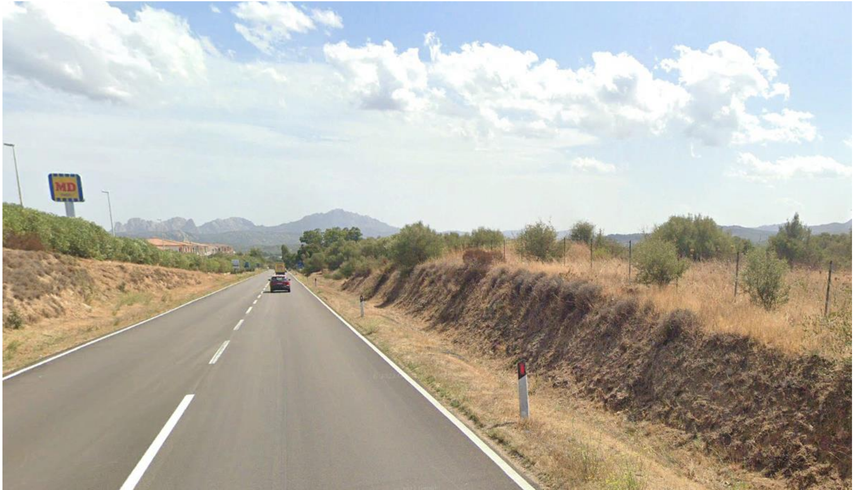
Punto 10 - Progressiva 0+500.00 del Tratto Sud: Punto di vista in corrispondenza della Circonvallazione di Arzachena, in direzione del viadotto in progetto VI01 che si sviluppa per 260 m. L'intervento ricade nella "Fascia Costiera" del PPR Sardegna.
