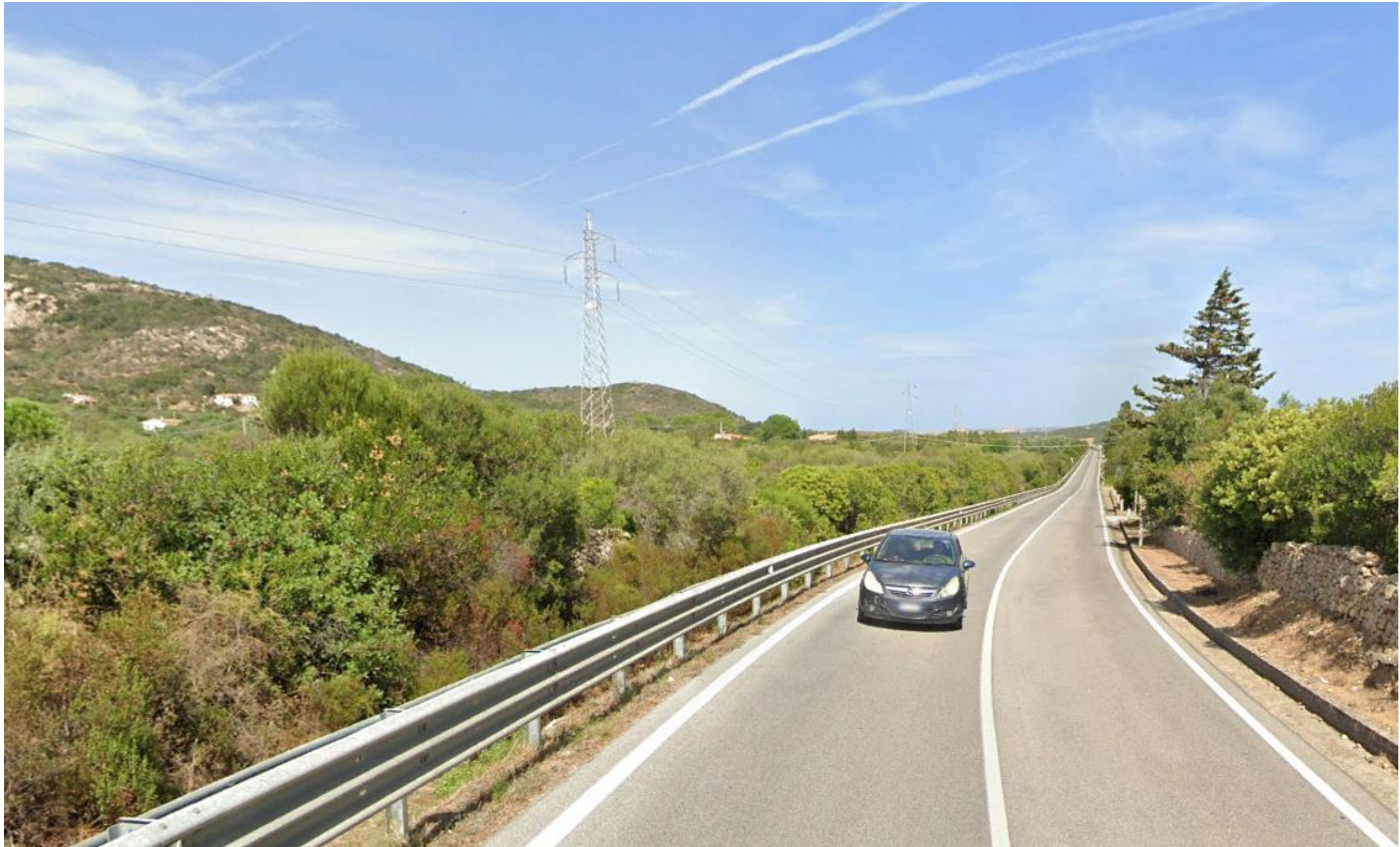
Punto 2 - Progressiva 1+160.00 del Tratto Nord. Vista dalla strada provinciale SP115 in direzione nord. Sia l'intervento che la presa fotografica ricadono in aree sottoposte a tutela paesaggistica dall'art. 142 del D.Lgs. 42/2004 "Fiumi, torrenti e corsi d'acqua e relative sponde per una fascia di 150 metri" – co. 1, lett. c. Il corso d'acqua è il Rio Surrau.
