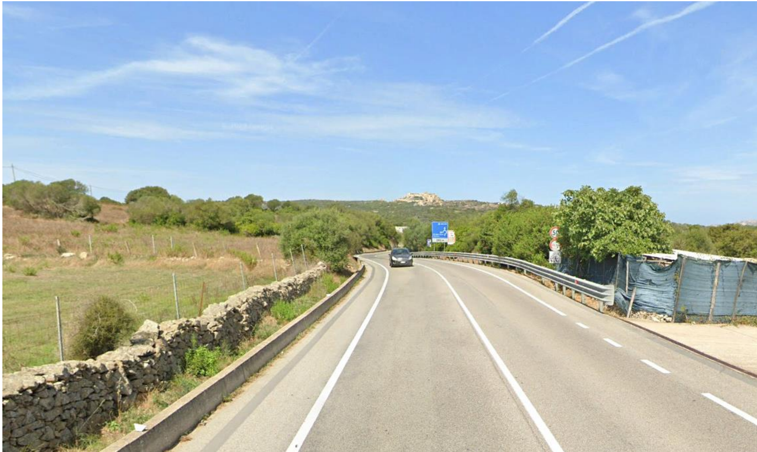
Punto 7 - Progressiva 3+320.00 del Tratto Nord: Vista dalla strada statale SS125, lungo il tracciato di progetto, in direzione nord, verso un tratto in trincea. L'intervento ricade in area sottoposta a tutela paesaggistica ai sensi dell'art. 142 del D.lgs. 42/2004 "Fiumi, torrenti e corsi d'acqua e relative sponde per una fascia di 150 metri" - co. 1, lett. c. Il corso d'acqua è il Rio Surrau e nella "Fascia Costiera" del PPR Sardegna.
