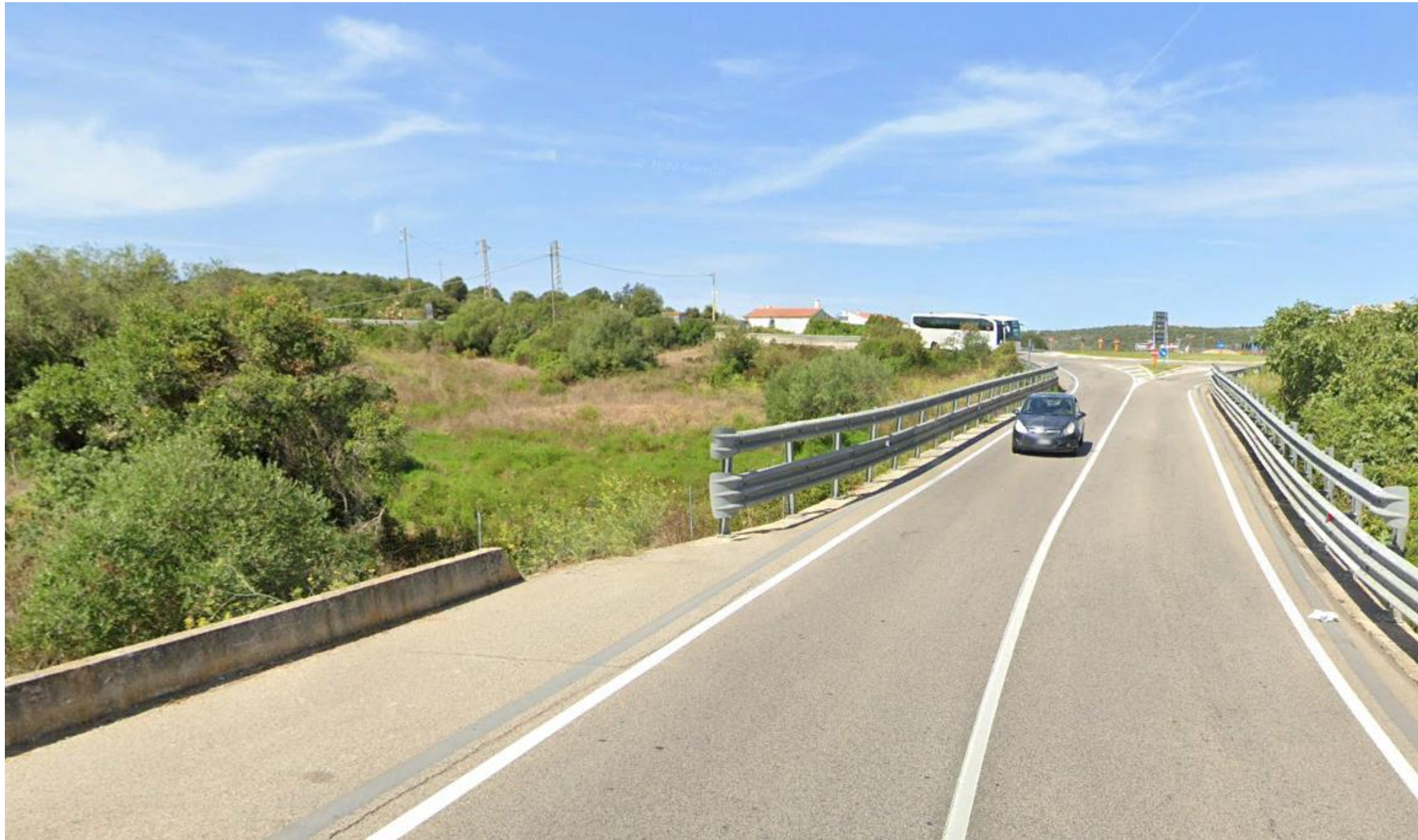
Punto 8 - Progressiva 3+580.00 del Tratto Nord: Vista dalla strada statale SS125 in direzione del viadotto in progetto VI06, che si sviluppa per 40 m, e della rotatoria esistente per Palau. L'intervento ricade in area sottoposta a tutela paesaggistica ai sensi dell'art. 142 del D.lgs. 42/2004 "Fiumi, torrenti e corsi d'acqua e relative sponde per una fascia di 150 metri" – co. 1, lett. c. Il corso d'acqua è il Rio Surrau e nella "Fascia Costiera" del PPR Sardegna.
