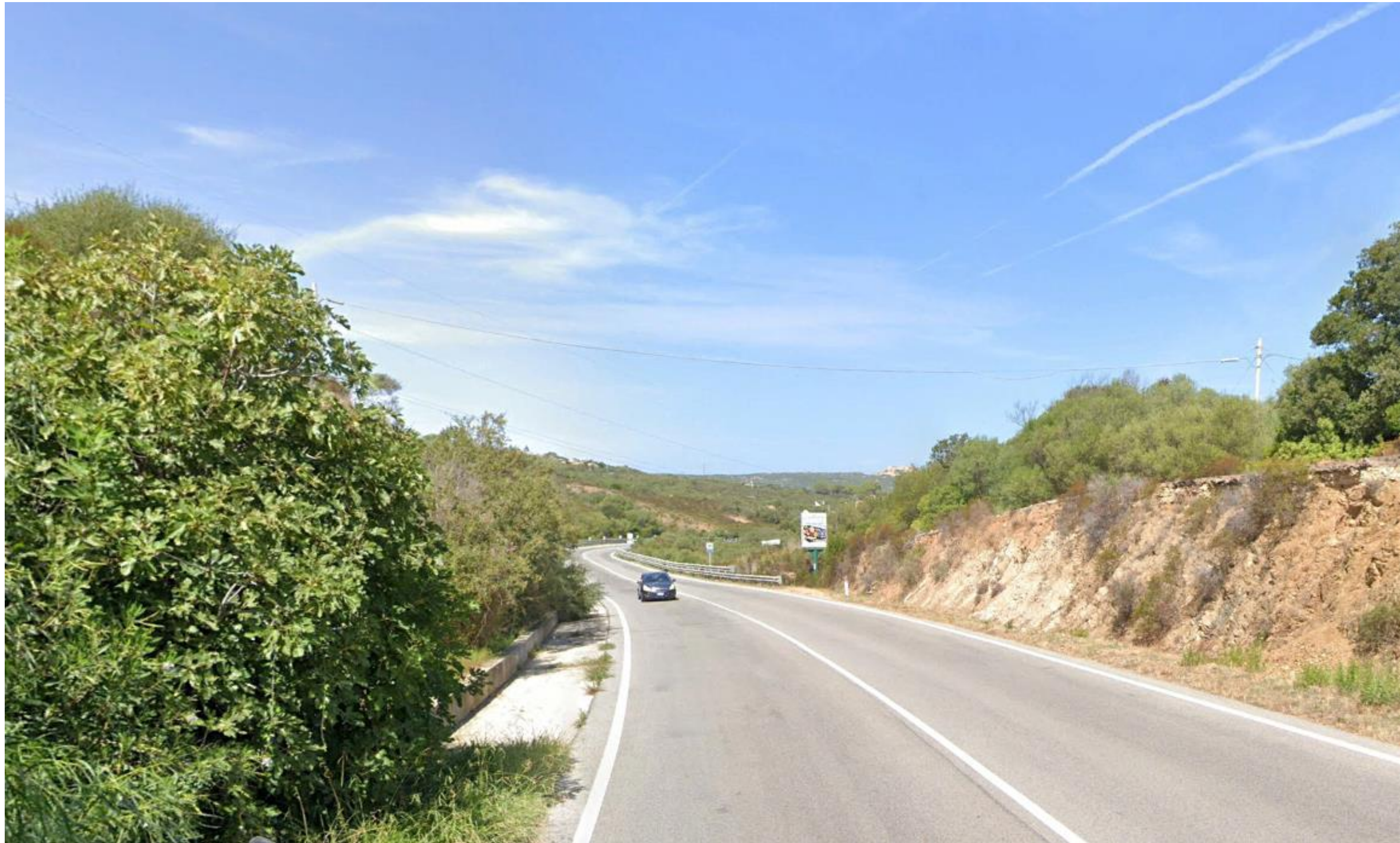
Punto 4 - Progressiva 1+900.00 del Tratto Nord: Vista dalla strada statale SS125 in direzione viadotto VI05 che si sviluppa per 40 m. L'intervento ricade in area sottoposta a tutela paesaggistica ai sensi dell'art. 142 del D.lgs. 42/2004 "Fiumi, torrenti e corsi d'acqua e relative sponde per una fascia di 150 metri" – co. 1, lett. c. Il corso d'acqua è il Rio Surrau e nella "Fascia Costiera" del PPR Sardegna.
