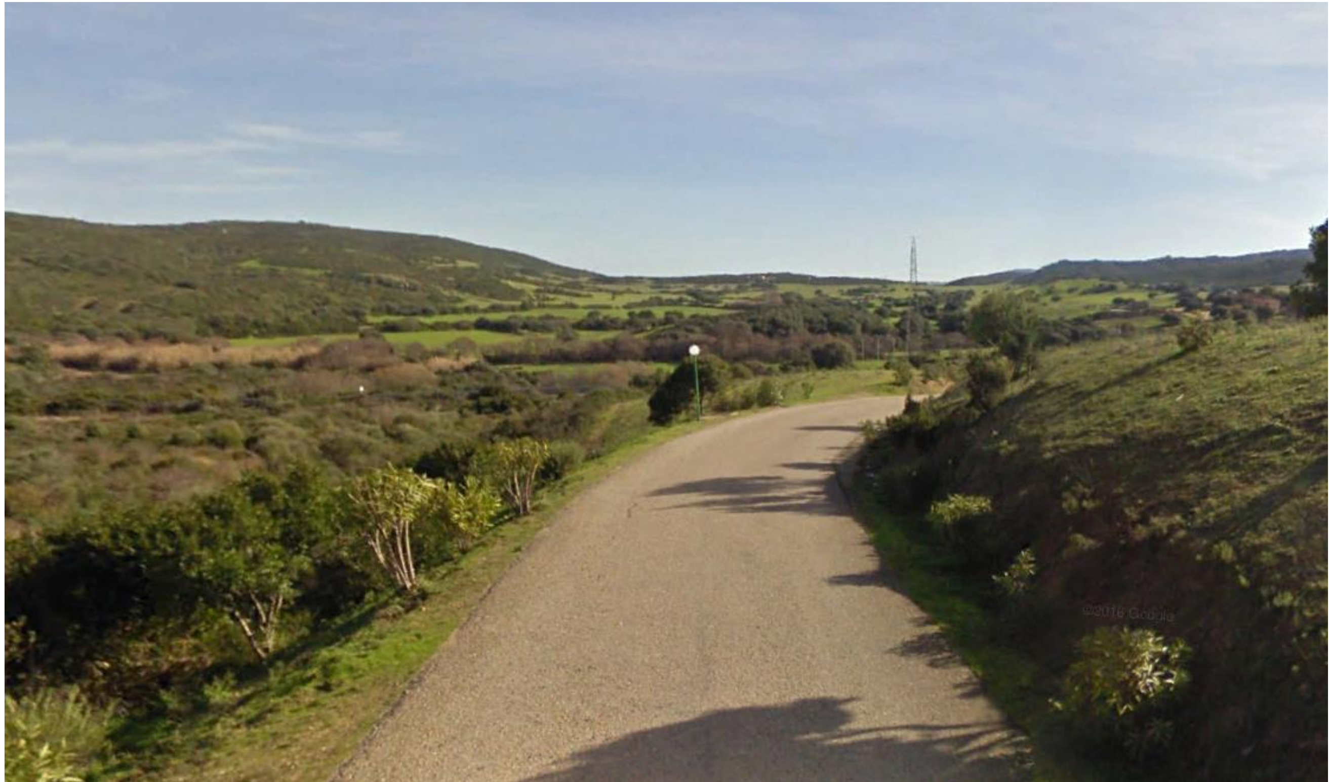
Punto 5 - Progressiva 2+437.54 del Tratto Nord: Vista dalla strada podereale per Località Pulcheddu in direzione della statale SS125 e della rotatoria ROT03. L'intervento ricade parzialmente in area sottoposta a tutela paesaggistica ai sensi dell'art. 142 del D.lgs. 42/2004 "Fiumi, torrenti e corsi d'acqua e relative sponde per una fascia di 150 metri" – co. 1, lett. c. Il corso d'acqua è il Rio Surrau, in parte in area individuata dal PPR Sardegna come bene identitario del "Parco geominerario ambientale e storico della Sardegna" (art. 143 del D.lgs. 42/2004) e completamente nella "Fascia Costiera" del PPR Sardegna.
