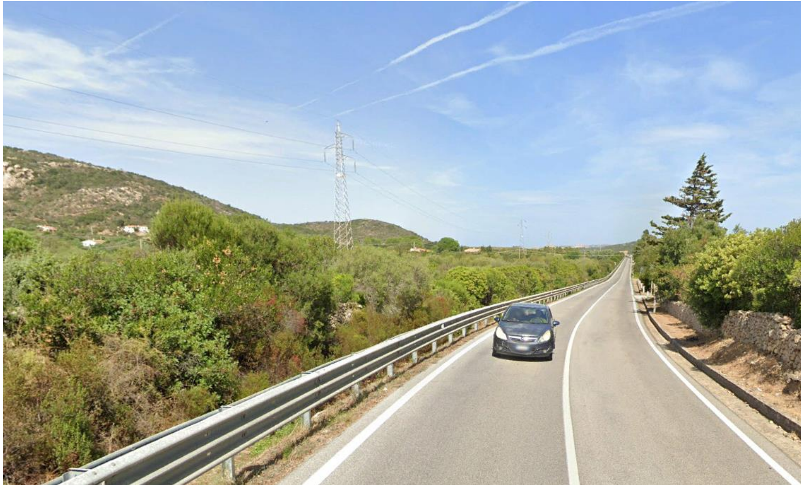
Punto 2 - Progressiva 1+160.00 del Tratto Nord. Vista dalla strada provinciale SP115 in direzione nord. Sia l'intervento che la presa fotografica ricadono in aree sottoposte a tutela paesaggistica dall'art. 142 del D.Lgs. 42/2004 "Fiumi, torrenti e corsi d'acqua e relative sponde per una fascia di 150 metri" – co. 1, lett. c. Il corso d'acqua è il Rio Surrau.
