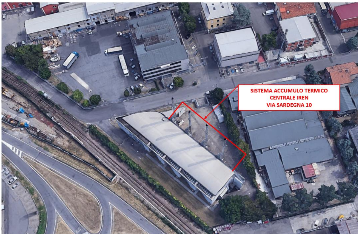
Figura 2.1: Vista della Centrale Termica di Via Sardegna con Localizzazione dell'Area di prevista Realizzazione del Nuovo Sistema di Accumulo Termico
