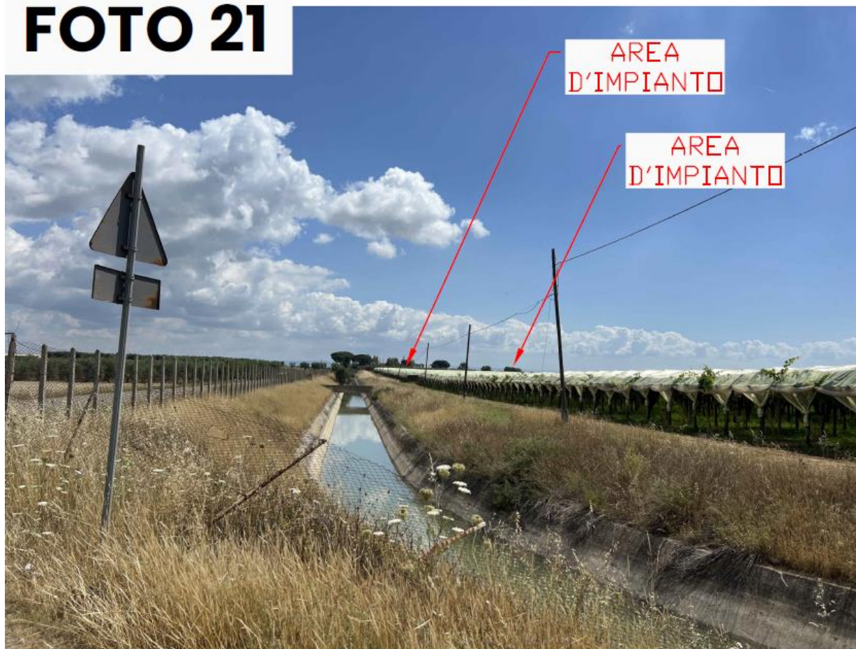
Figura 42: Analisi visiva dell'area di impianto con mappatura delle interferenze esistenti da Edificio Rurale (punto 21)
