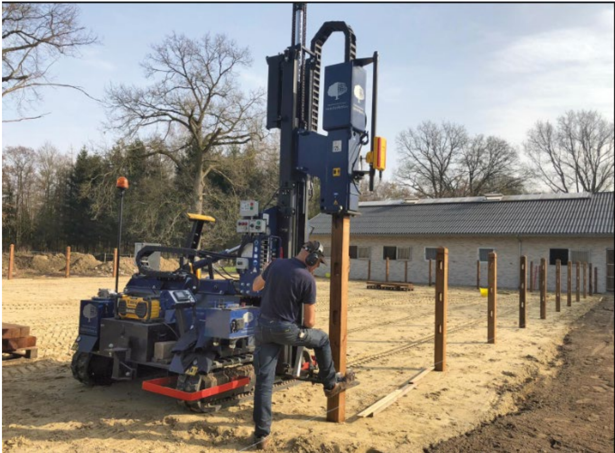
Figura 1: Utilizzo di macchina batti palo con mezzo escavatore, per l'installazione meccanica dei pali di sostegno per la recinzione
