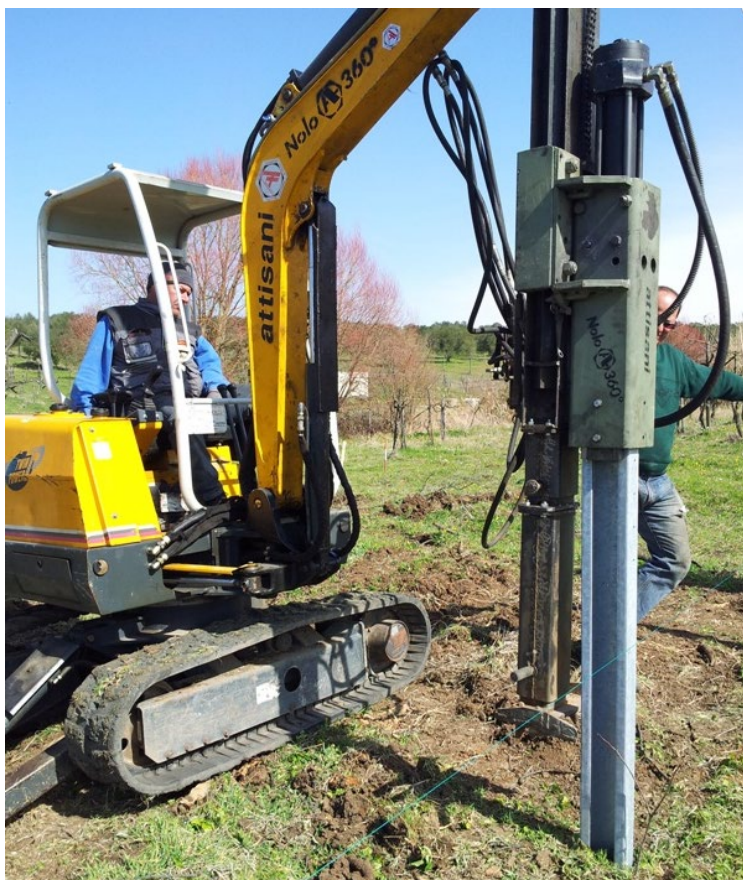
Figura 3: Dettaglio delle strutture in acciaio infisse su terreno
