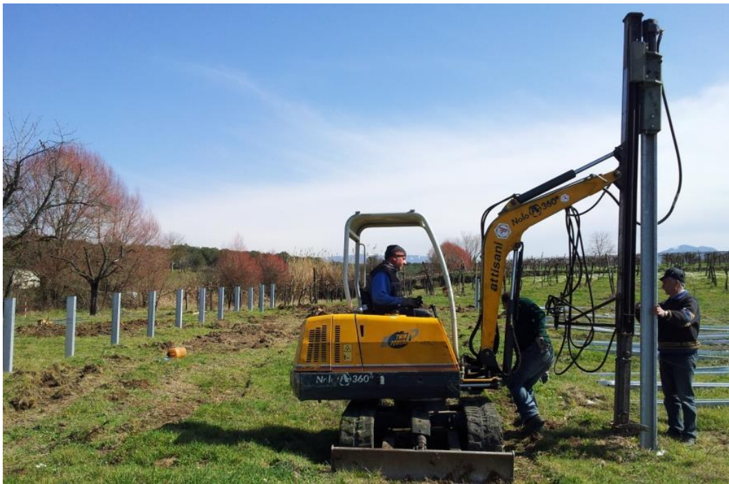
Figura 3: Tecnica di realizzazione di fondazioni Tracker
