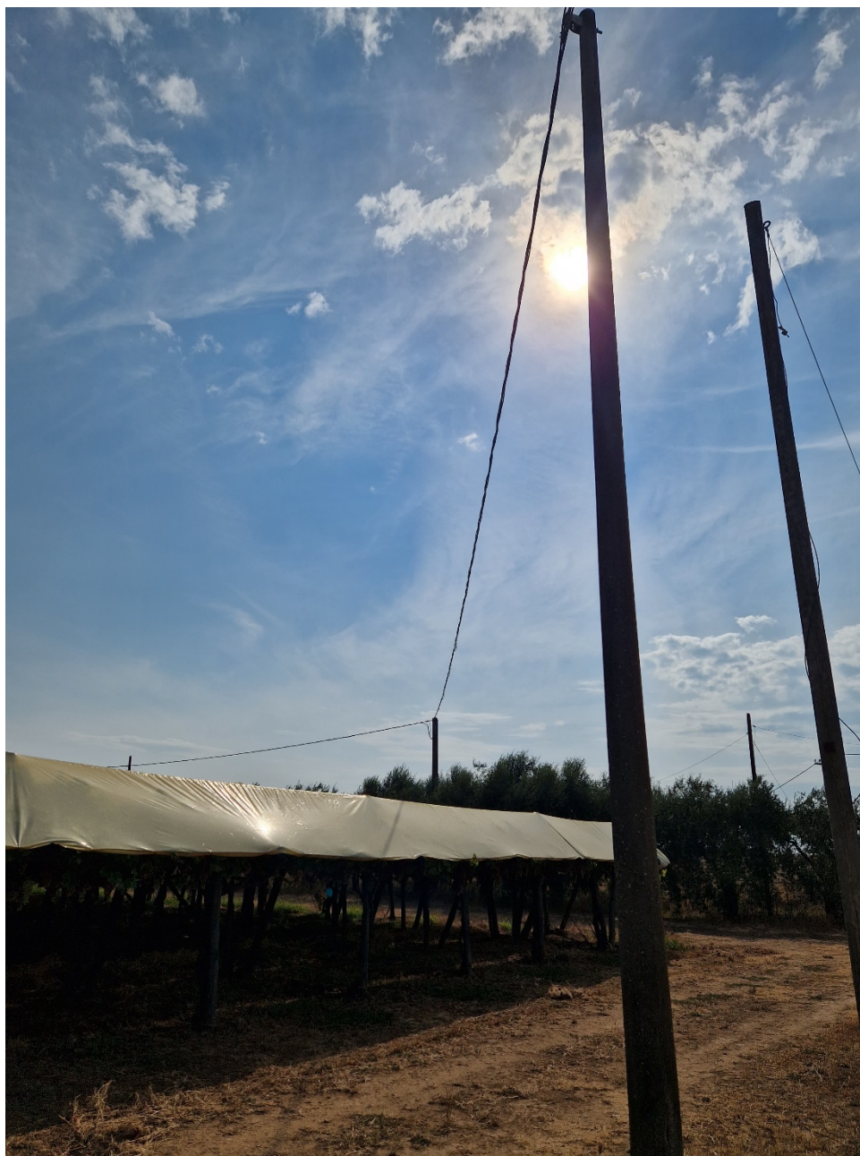
Figura 24: Foto dell'area catastale in disponibilità con evidenza della linea elettrica presente
