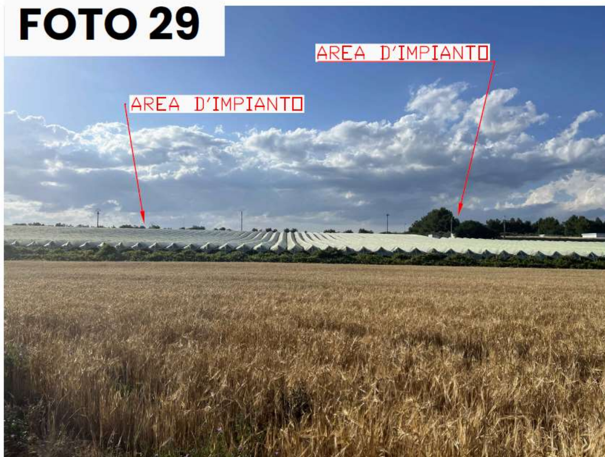
Figura 94: Analisi visiva dell'area di impianto con mappatura delle interferenze esistenti da Masseria Scollato (punto 29)
