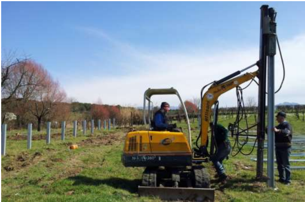
Tecnica di realizzazione di fondazioni Tracker
