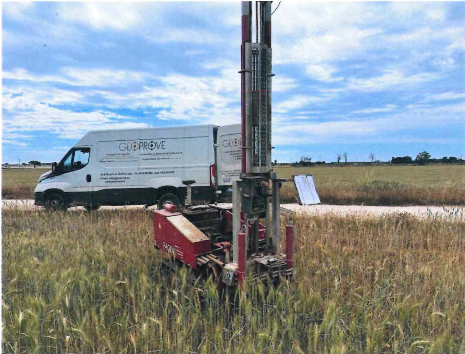
Esecuzione prova penetrometrica DPSH 4
