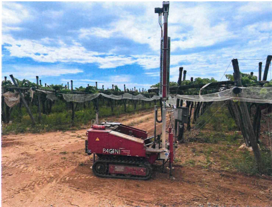
Esecuzione prova penetrometrica DPSH 6
