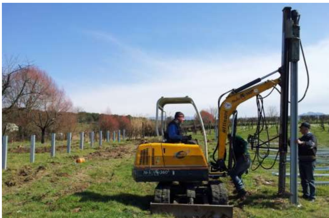
Figura 3: Tecnica di realizzazione di fondazioni Tracker
