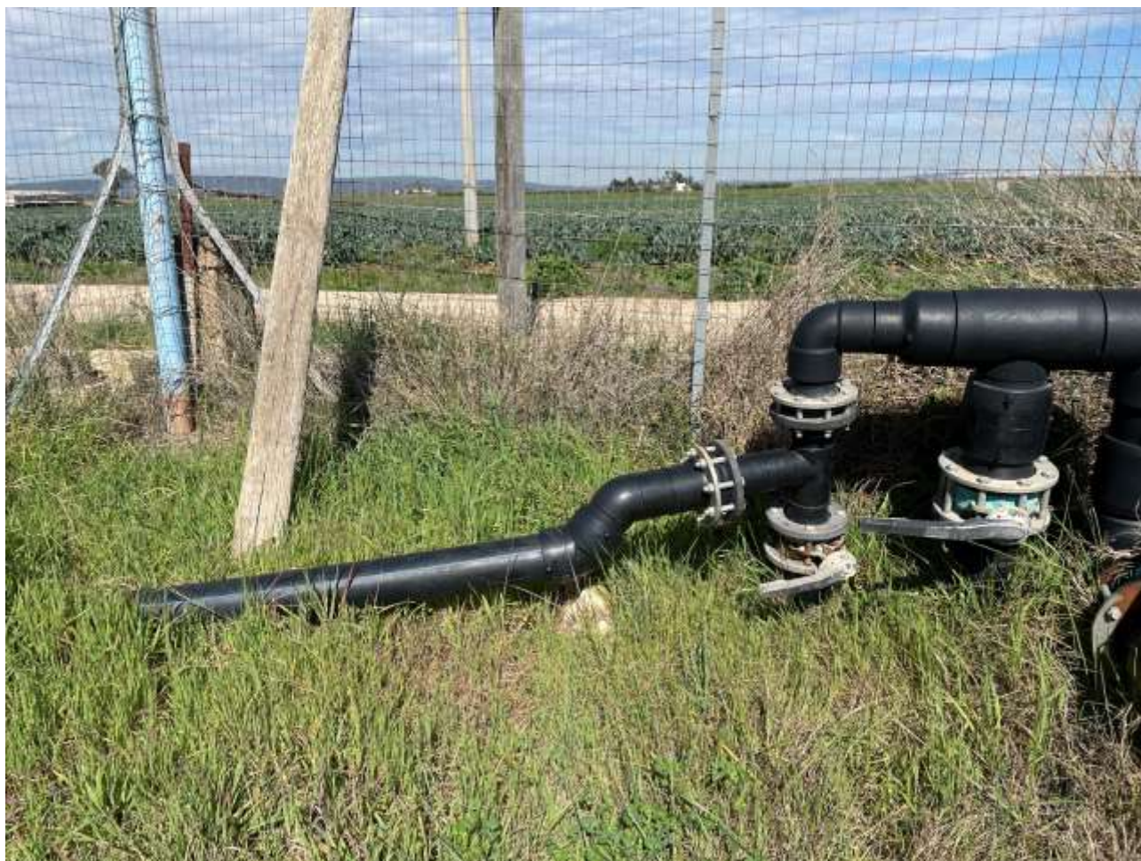
Figura 27: Foto dell'area catastale in disponibilità con evidenza delle bocchette del consorzio presenti
