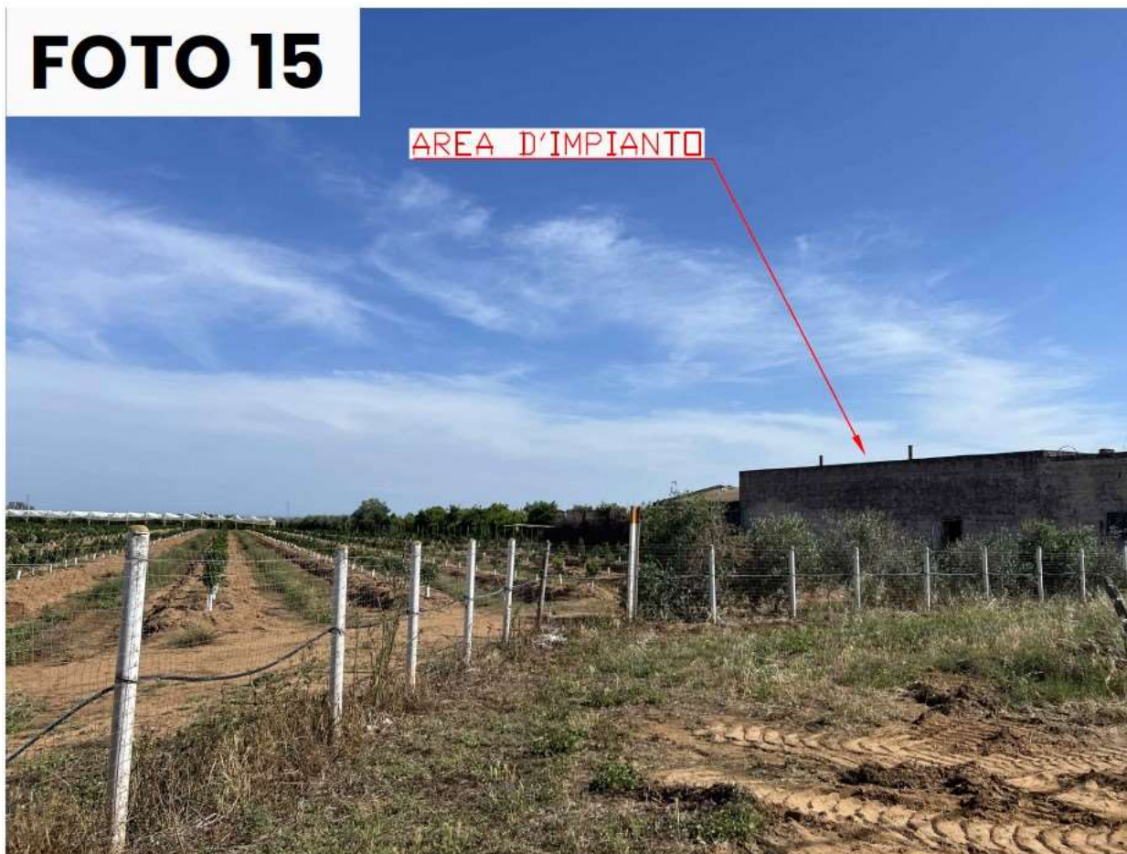
Figura 77: Analisi visiva dell'area di impianto con mappatura delle interferenze esistenti da Masseria Festa (punto 15)
