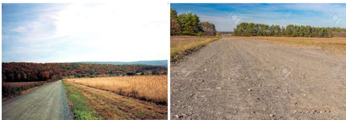
Figura 125: esempio strade sterrate
