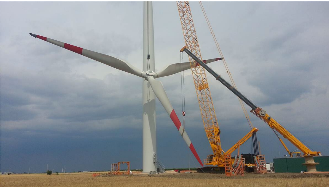
Figura 2. Smontaggio delle pale
