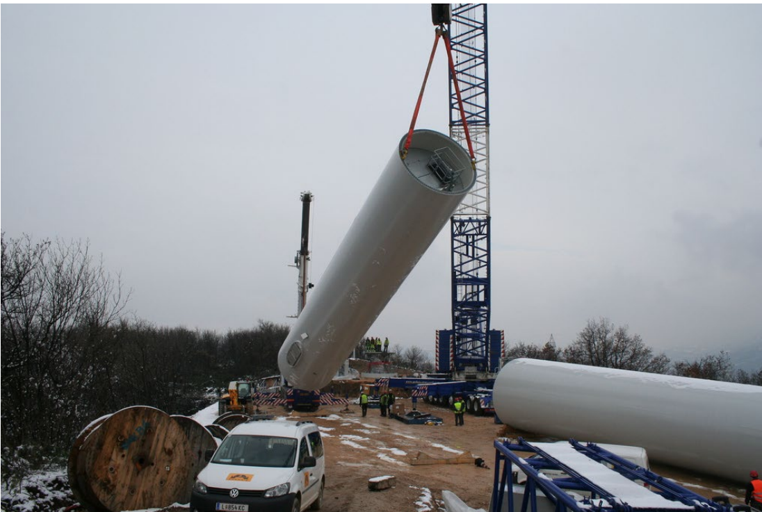
Figura 3. Smontaggio dei tronchi
