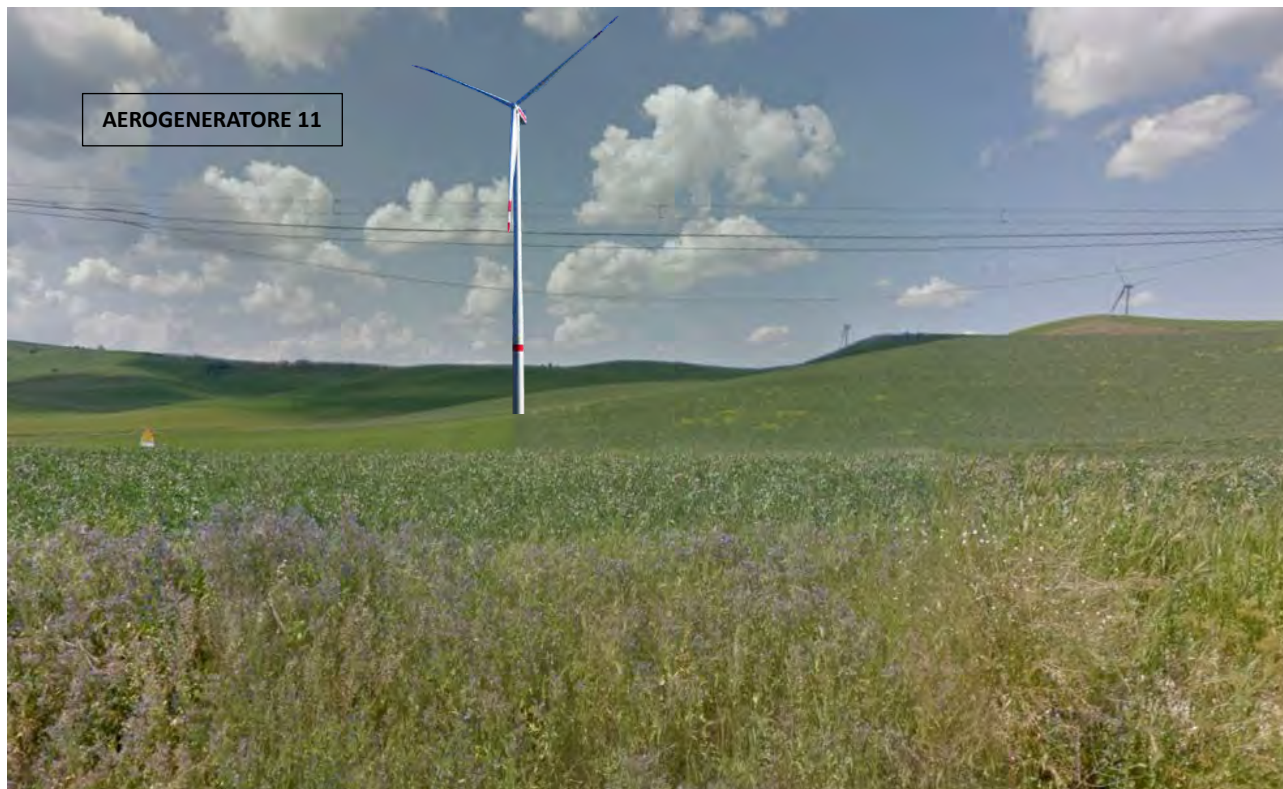
Figura 21. Vista dell'area in prossimità dell'aerogeneratore WTG 11.
