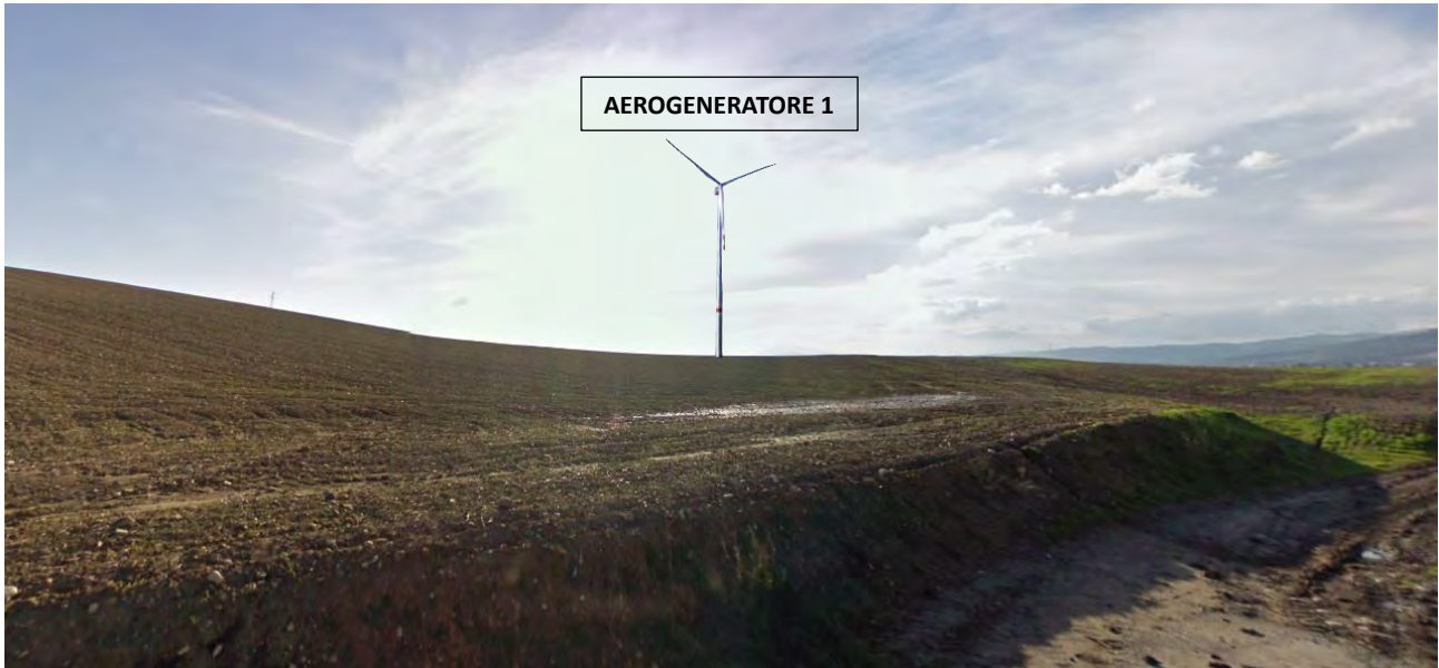
Figura 11. Vista dell'area in prossimità dell'aerogeneratore WTG 1.
