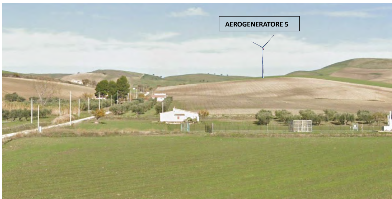
Figura 15. Vista dell'area in prossimità dell'aerogeneratore WTG 5.
