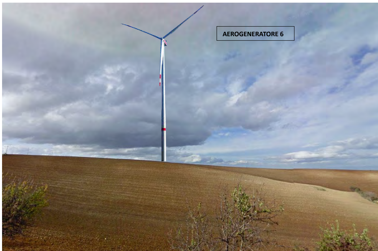
Figura 16. Vista dell'area in prossimità dell'aerogeneratore WTG 6.
