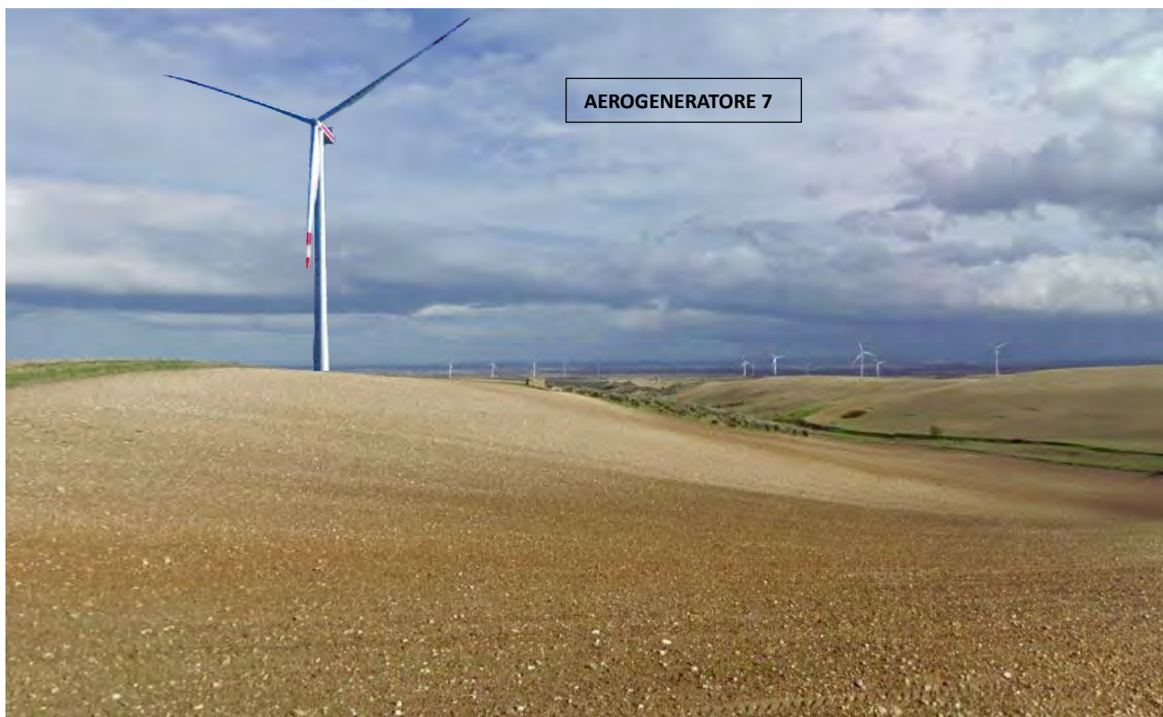
Figura 17. Vista dell'area in prossimità dell'aerogeneratore WTG 7.
