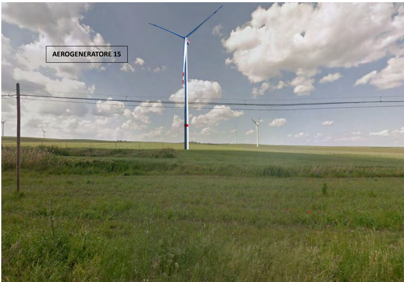
Figura 25. Vista dell'area in prossimità dell'aerogeneratore WTG 15
