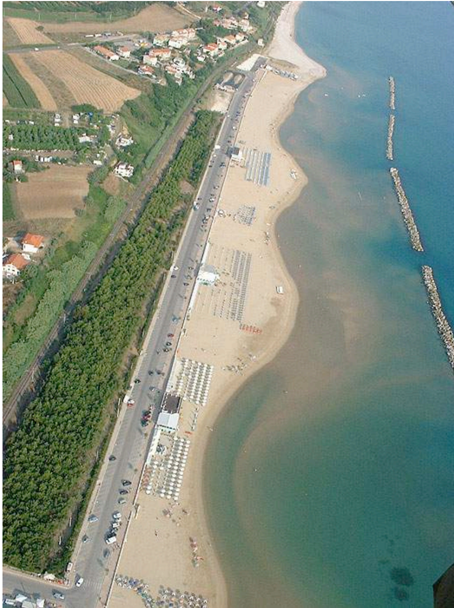
FIG. 10: Litorale di Torino di Sangro. La piattaforma Ombrina Mare e lo stazionamento FPSO saranno visibili dalla riva.
