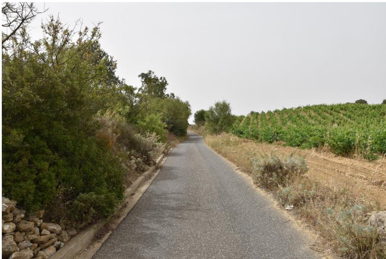
Figura 3-4 - Tratto di viabilità da adeguare della stazione WTG01.
