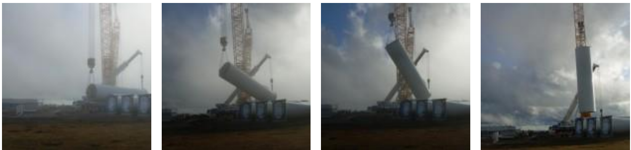
Figura 5.48 – Schema delle fasi di sollevamento dei componenti dell'aerogeneratore (Fonte sito web http://www.windfarmbop.com/ )
