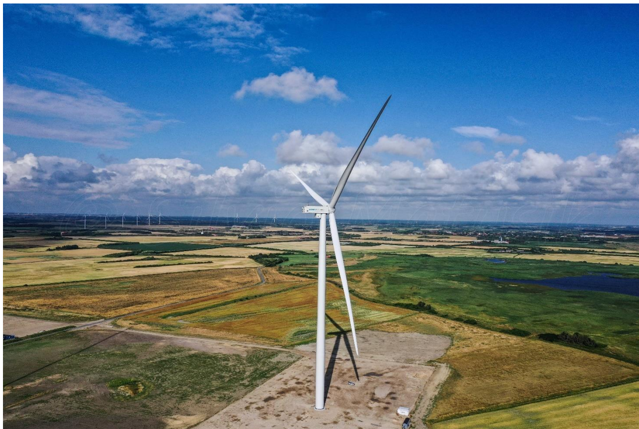
Figura 6.1 – Aerogeneratore tipo SG 6.2-170 AM0
