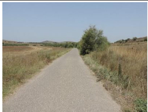
Stradello di avvicinamento a WTG06
