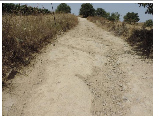
Stradello di avvicinamento a WTG09
