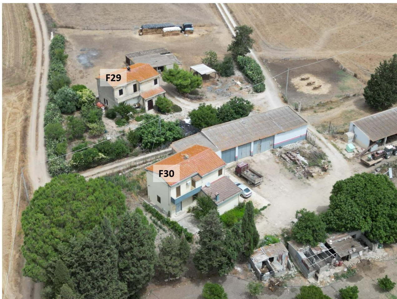
Figura 6.2 – Fabbricato F30 – Vista aerea da sud. Si noti la presenza della fitta cortina arborea sul lato sudovest
