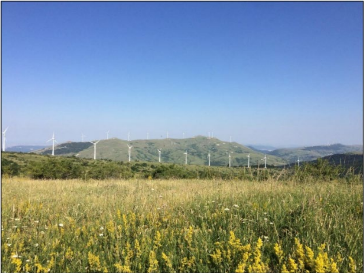
Figura 21: Dettaglio panoramico dell'impianto esistente (zona Sud)
