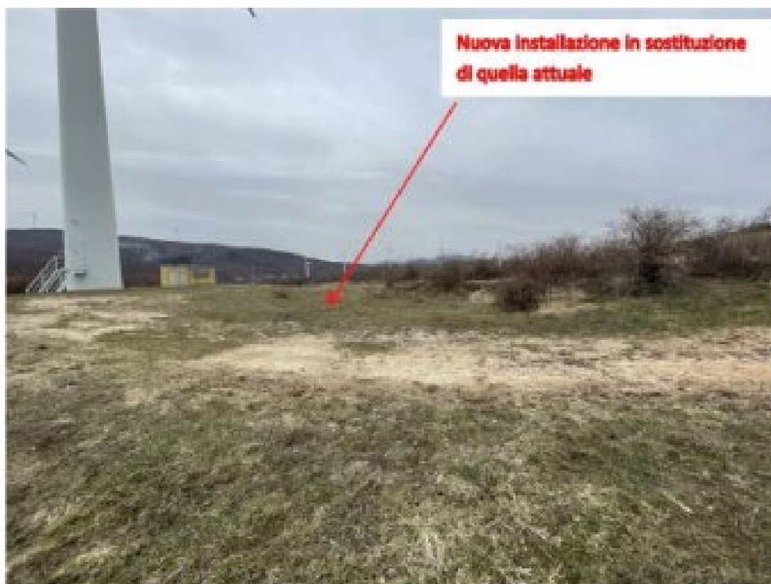
Figura 28: Immagini dei siti degli impianti MZ1 sopra e MZ2 sotto (cfr. Fig. 5.1 All. A Pes. Rev.1)
