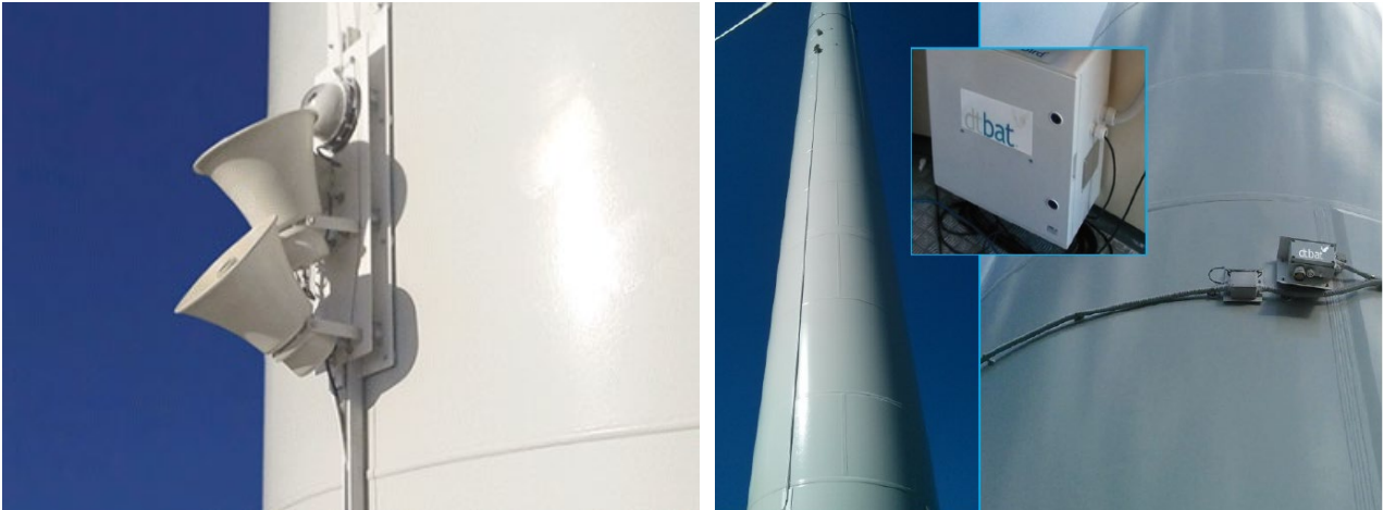
Figura 2 – Metodo standard di installazione moduli di Monitoraggio e/o Riduzione collisione (fonte: sito web DTBird)
