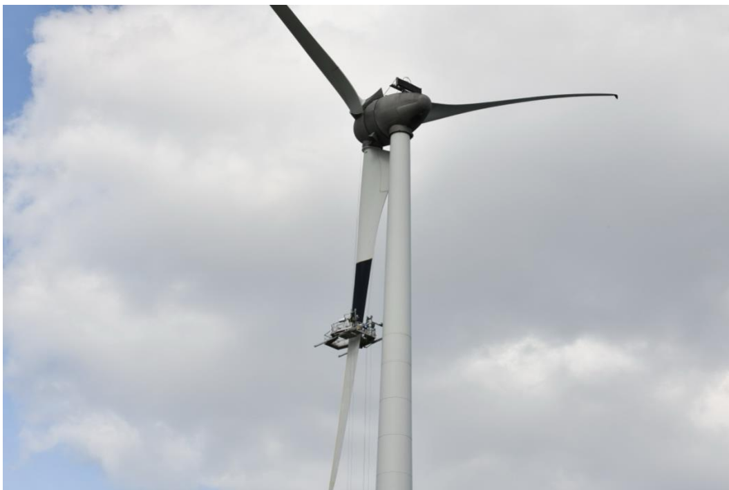
Figura 4.1 Dipingere una pala nera nel settembre 2022. Foto: Alex Wiersma, provincia di Groningen.
