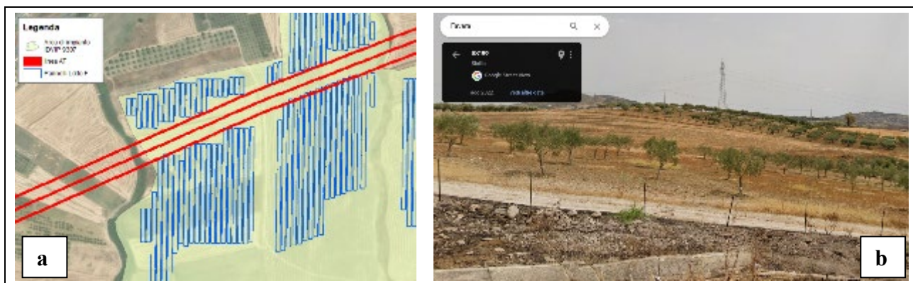
Figura 2 – Tracciato della linea AT, e relativa fascia di rispetto all’interno del Lotto F. Fonte: elaborazione della Commissione (a) e vista del traliccio di alta tensione dalla SS189 (b)
