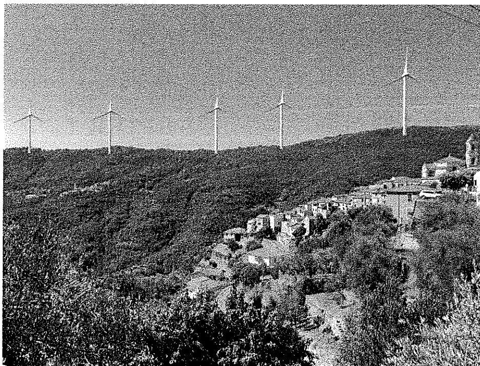
Figura 7 - Pietrabruna e Boscomare dopo l'installazione degli aerogeneratori
