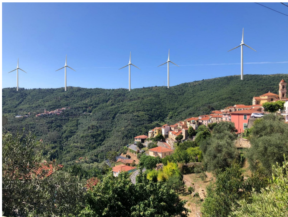
Figura 7 - Pietrabruna e Boscomare dopo l'installazione degli aerogeneratori
