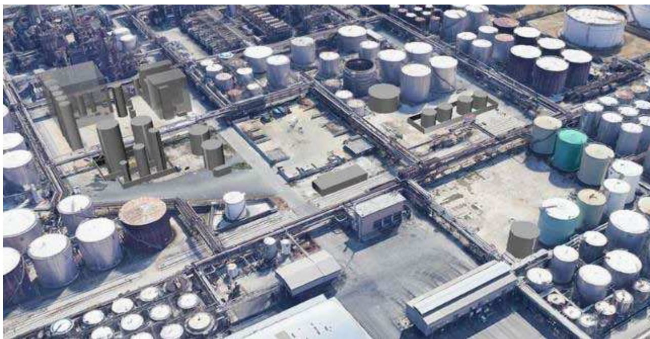
Figura 5 - Vista PTU e UCO/RUCO da nord-est
