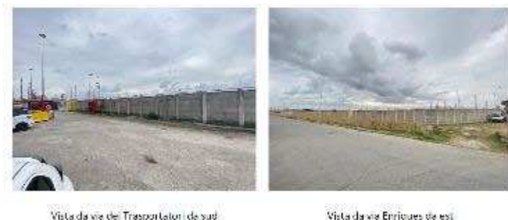
Figura 43 - viste su recinzione esistente
