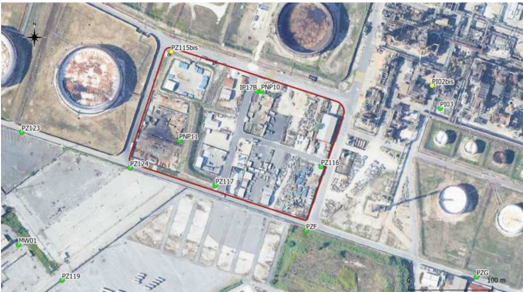
Figura 30 - Piezometri di monitoraggio (gialli) e MISE (verdi) presso l'area Ecofining+SR.
